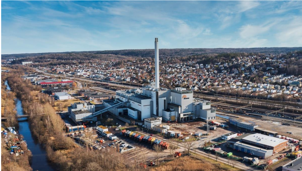
Befintlig anläggning, sett västerifrån. Bild: Renova
