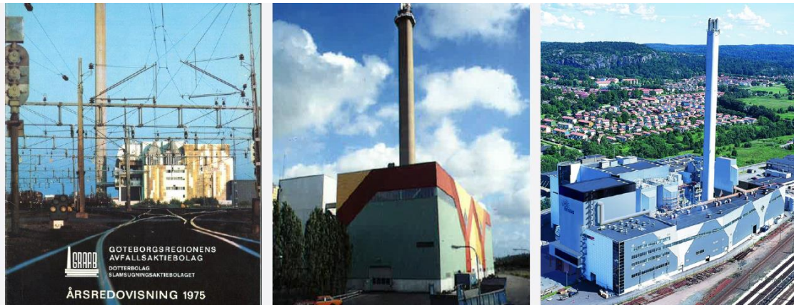
Utseende på avfallskraftvärmeverket 1975, 1985 och 2010. Bild: Liljewall
